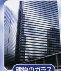
建物のガラス
